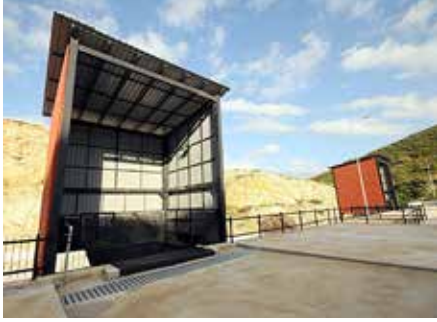
Urla Katı Atık Transfer İstasyonu
