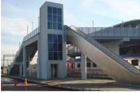
Halkapınar İstasyonunda 2 Adet Yaya Üst Geçidi Yapılması İşi
