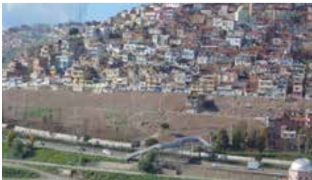
Yeşildere Heyelan Bölgesi Yıkımdan Sonra
