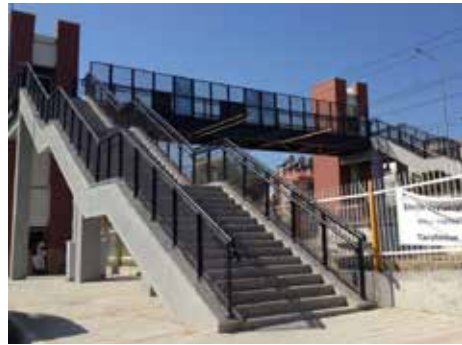
Gazimir İlçesi 9 Eylül Mahallesi Yaya Üst Geçidi
