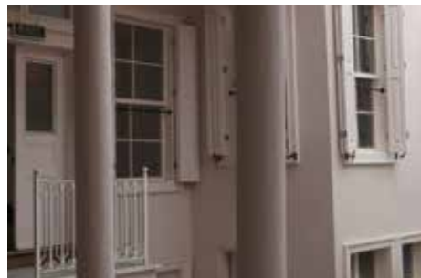
Konak Pazaryeri Mahallesi Restorasyon Çalışması
