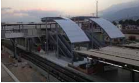
Halkapınar İstasyonunda 2 Adet Yaya Üst Geçidi Yapılması İşi
