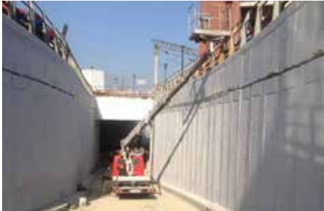
Akıncılar Karayolu Alt Geçidi
