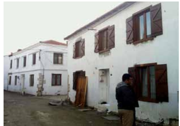
Sığacık Kale İçi Sokak Sağıklaştırma Çalışmaları
