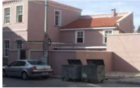
Buca Kasaplar Meydanı Restorasyon Çalışmaları
